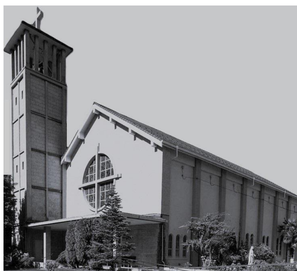
カトリック北仙台教会、1951 年（昭和 26）完成。この荘厳な建造物に目と心を奪われたことがきっかけで、大槻青年の人生は新たな方向に展開した。
